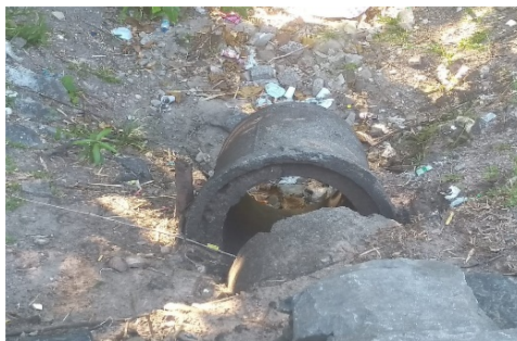
Imagem 12. Tubulação em más condições de funcionamento exposta. Fonte: Autores, 2018.
