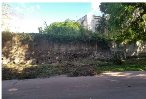
Imagem 8. Muro que limita o condomínio residencial do parque. Fonte: Autores, 2018.
