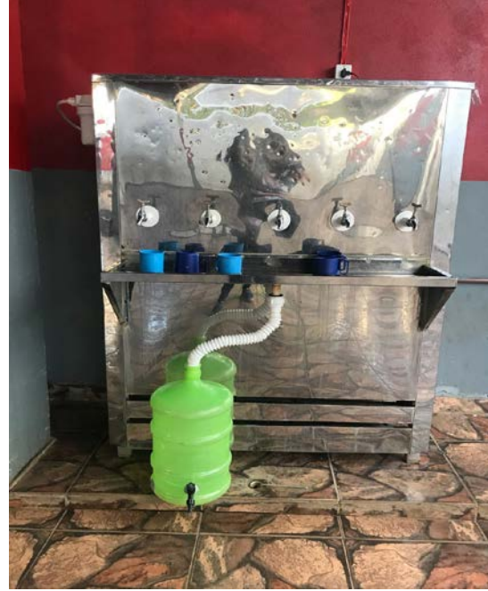
Figura 7 e 8. Sistema de captação de água desperdiçada finalizado e implantado nos bebedouros. Fonte: Autora (2018)
