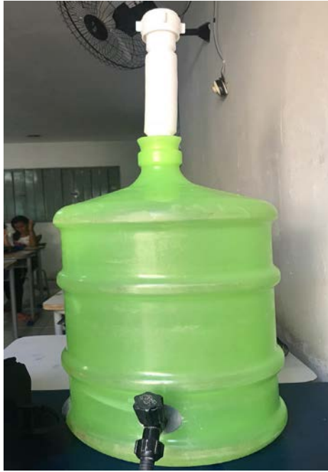
Figura 7 e 8. Sistema de captação de água desperdiçada finalizado e implantado nos bebedouros. Fonte: Autora (2018)
