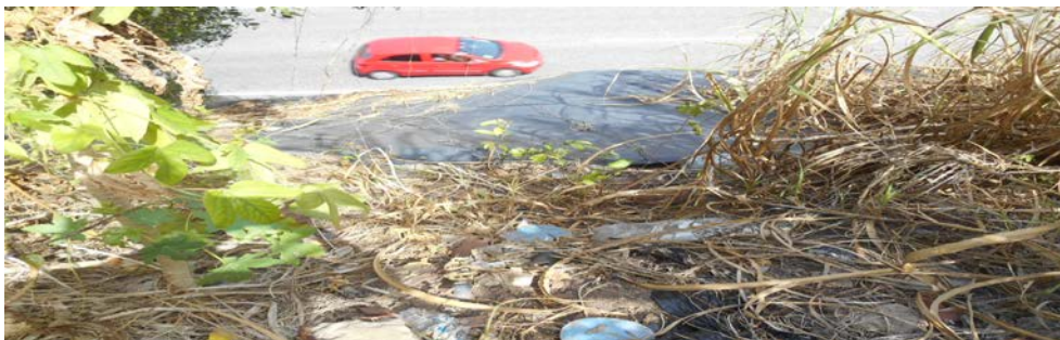
Figura 8 - Lixo acumulado no talude da encosta, Comunidade Santa Clara (BR-230, km 19). Fonte: Acervo do autor (2016).
