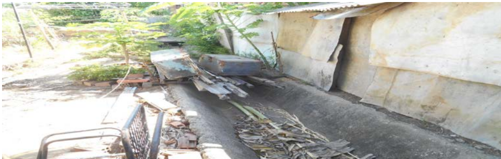
Figura 6. Canaleta de drenagem da vertente na Comunidade Santa Clara, BR-230, km 19, obstruída. Fonte: Acervo do autor (2016).
