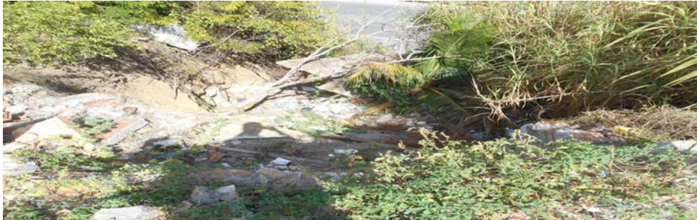
Figura 5. Local onde se encontrava a escadaria de drenagem que foi destruída na encosta da Comunidade Santa Clara voltada para a BR-230, km 19. Fonte: Acervo do autor (2016).
