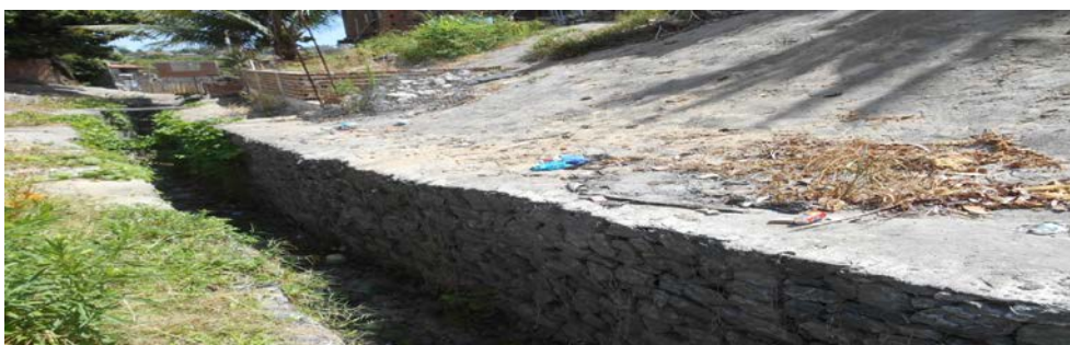
Figura 10. Muro gabião de granito na Comunidade Santa Clara. Fonte: Acervo do autor (2016).
