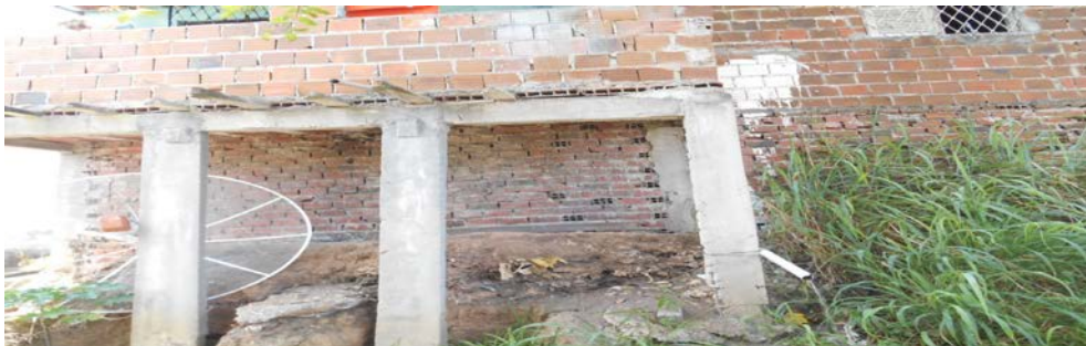
Figura 7. Casa no topo da encosta na Comunidade Santa Clara lançando águas servidas. Fonte: Acervo do autor (2016).
