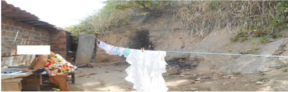
Figura 11. Corte de talude na Comunidade São Rafael. Fonte: Acervo do autor (2016).
