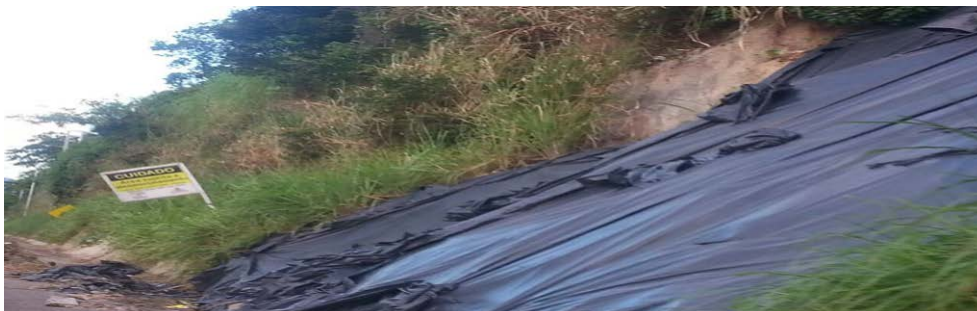
Figura 3. Talude da Comunidade Santa Clara sujeito a movimentação de massa. BR- 230, km 19. Fonte: Moura (2014).
