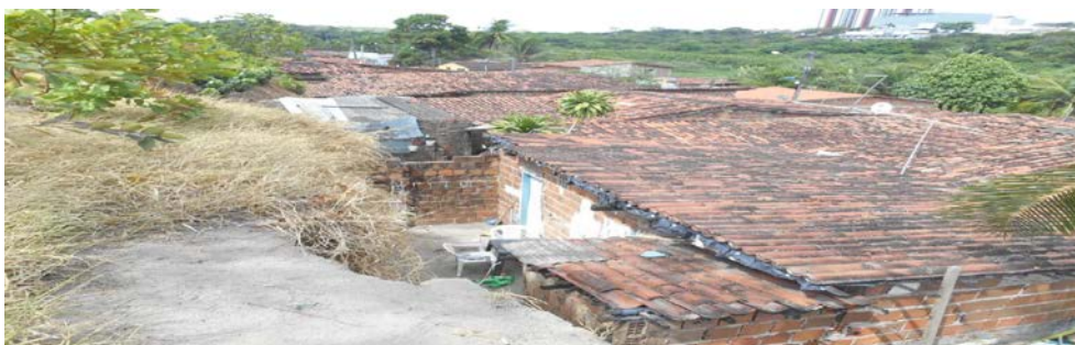
Figura 4. Casas situadas na Comunidade São Rafael muito próximas ao talude de corte. Fonte: Acervo do autor (2016).
