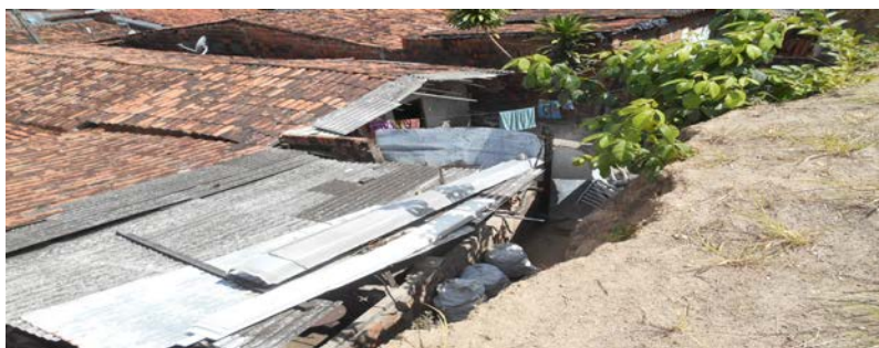
Figura 2. Corte de talude na Comunidade São Rafael. Fonte: Acervo do autor (2016).
