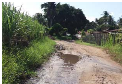
Figura 7. Fluxo de esgoto doméstico, escoando a céu aberto em Mamanguape. Fonte: Autores (2016).
