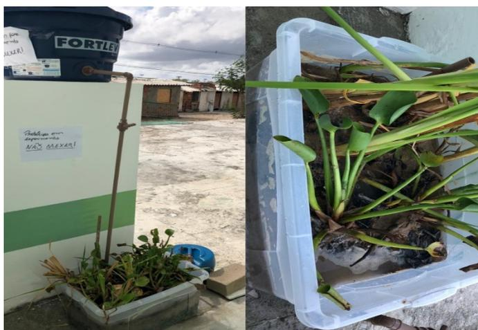
**Figura 2.** Tratamento de água residual de Águas Cinzas via Wetlands Construídos.
