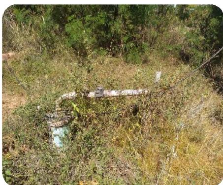
*Figura 3: Registros acoplados à rede de distribuição.*
