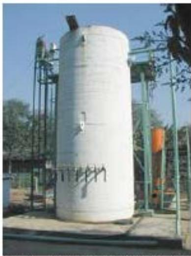
Figura 1 – Biodigestor Modelo RAFA.
