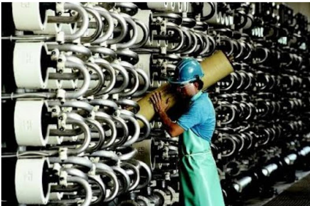
**Figura 9.** Usina de dessalinização por osmose reversa. **Fonte:** Dessalinizadores e seus sensores.
